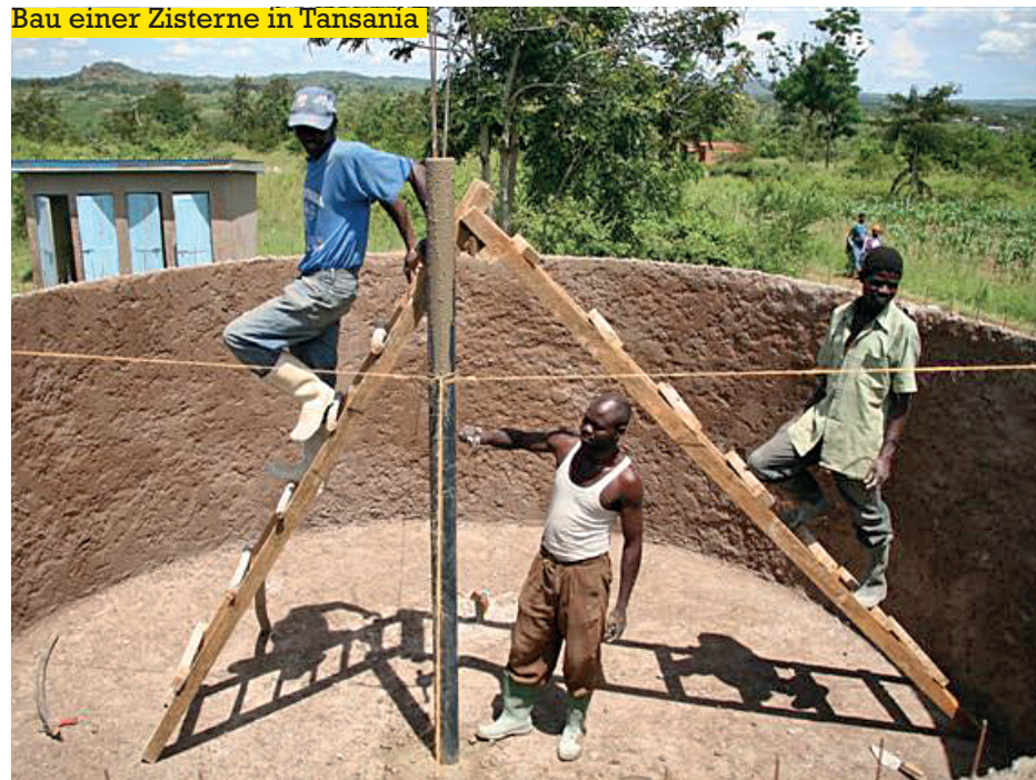
Bau einer Zisterne in Tansania
